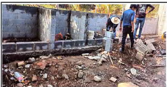
Foto 5: Baños en proceso de rehabilitacion
