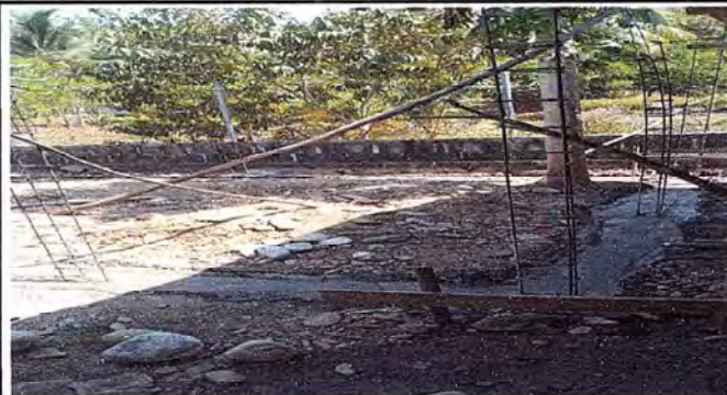
Foto 2: Inicio de rehabilitacion de cocina.
