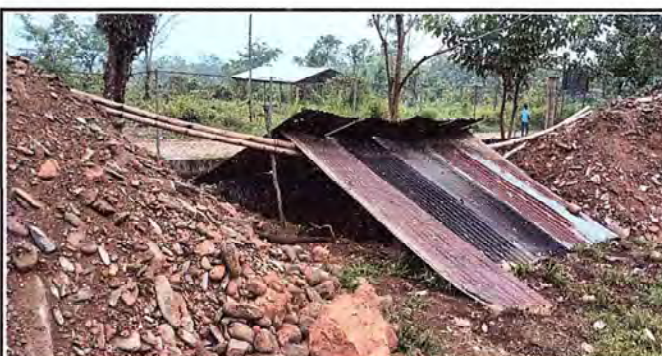
Foto 6: fosa septica en proceso de rehabilitacion.
