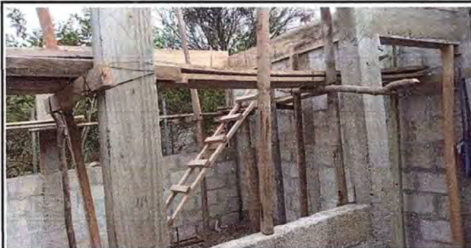
Foto 1: Cocina parte de enfrente, trabajo en proceso
