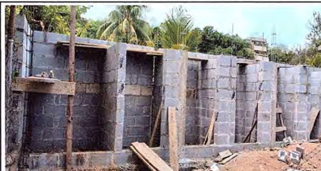
Foto 4: baños en proceso de rehabilitacion.
