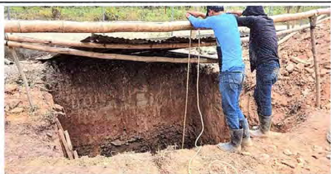
Foto 3: Fosa septica en proceso de rehabilitacion.
